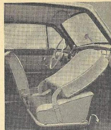
Abb. 20: Beifahrersitz mit Verstellhebel 1/57/1128
