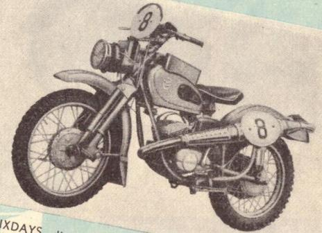
ADLER-SIXDAYS, die erfolgreichste Maschine der XXXI. Internationalen Sechstagesfahrt 1956, Zweizylinder-Zweitakt, 250 ccm, 18 PS bei 6200 U/min, 4 Gänge, Vollschwingen-Fahrwerk mit besonders kräftigen, ölgedämpften Federbeinen, Bereifung vorn: 3,00-19, hinten: 3,50-18.
